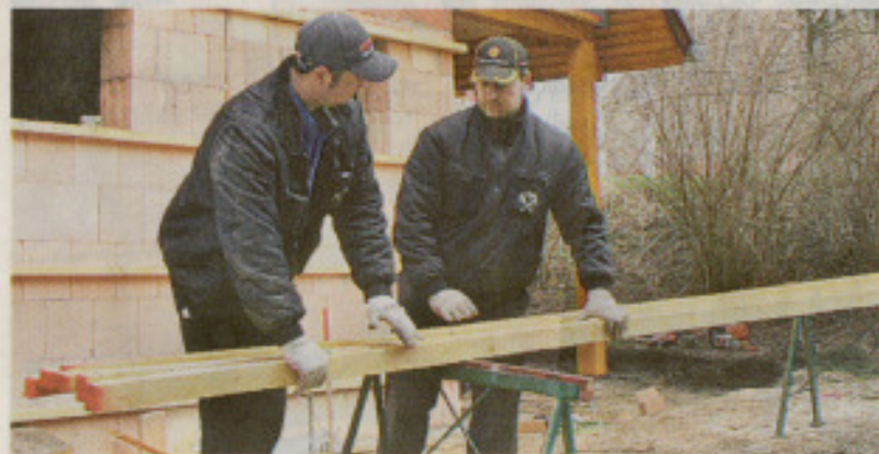
Die Männer der Dachdeckerei Krumm aus Mirow haben in den vergangenen Tagen den Dachstuhl des neuen Dusch- und Toilettenhauses fertig gestellt.
